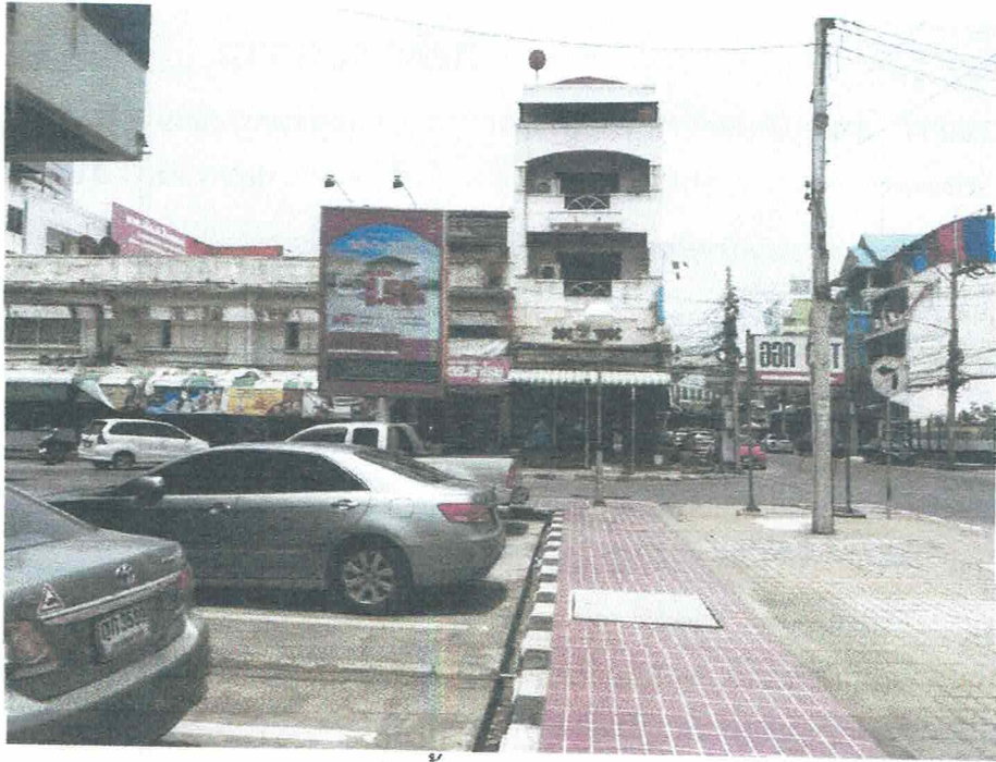
จุดติดตั้งบริเวณทางออก
